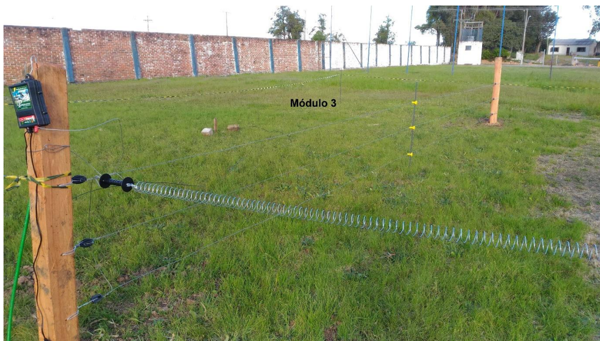
Figura 6: Módulo 3 com 2 fios elétricos e 1 fio aterrado.
